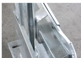
Nun den Pfosten mit dem Stützbügel, der Unterlegscheibe und der Mutter montieren.
