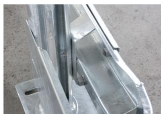
Nun den Pfosten mit dem Stützbügel, der Unterlegscheibe und der Mutter montieren. Schritte mit der zweiten Planke wiederholen.
